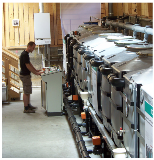
Abb. 25: Grauwassernutzungsanlage in einem Berliner Wohnkomplex (Sustainable Sanitation Alliance, CC BY-SA 2.0).
