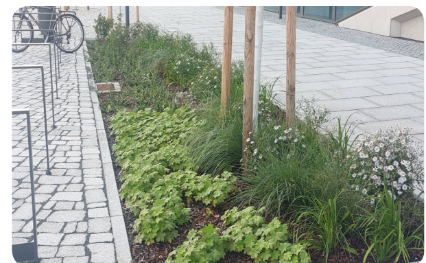
Abb. 29: Sickermulde mit trockenheitstoleranten Stauden, z.B. Gipskraut, Blut-Storchschnabel, Wild-Aster (TU Dresden).
