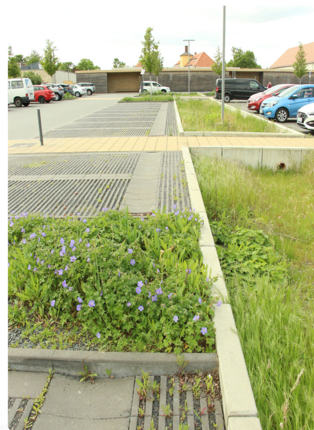
Abb. 39: Tiefbeet-Rigolen auf dem Parkplatz des Schloss Pillnitz in Dresden (TUD 2025).
