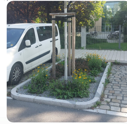
Abb. 41: einfache Baumrigole in der Lili-Elbe-Straße in Dresden (TUD 2025 nach BlueGreenStreets Teil A 2022: 116, Abb. 91).
