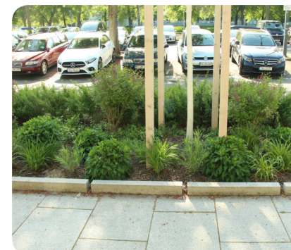
Abb. 42: geschlitzte Borde als Niederschlagszuleitung zu einer Baumrigole am Pirnaischen Platz in Dresden (TUD 2025).
