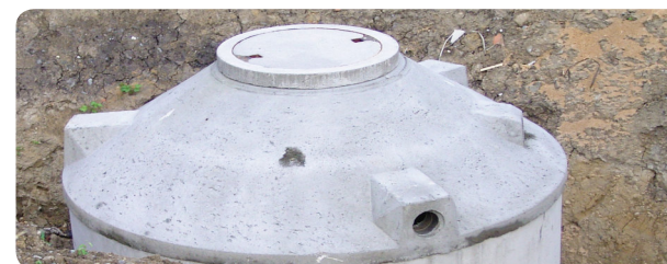
Abb. 18: Betonzisterne während des Einbaus mit sichtbaren Einläufen (Stefan-Xp, CC BY-SA 3.0).
