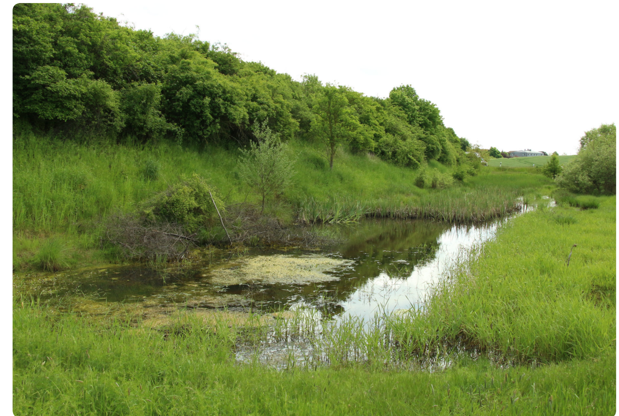
Abb. 34: Ein naturnah gestaltetes Regenrückhaltebecken mit Flachwasserzone, Tiefwasserzone und Gehölzen (TU Dresden).
