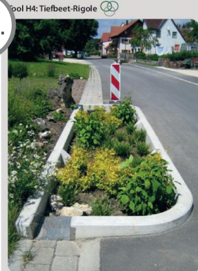
Tiefbeet-Rigole im Straßenraum. Die Zuleitung des Niederschlagswassers erfolgt über eine offene Rinne am Straßenrand und den Schacht am Beetrand. (Stieker o. J.: Tiefbeet-Rigolen)
