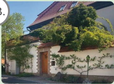
Mauerfassadenbegrünung mit Seilsystem. (Stadt Leipzig et. al 2022: 9)
